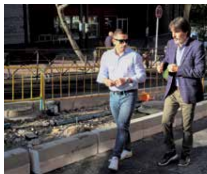
▲ El vicescalde, en su visita a las obras de remodelación.
