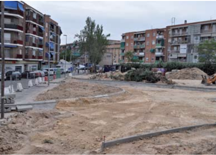
Punto donde se están realizando las reformas.
