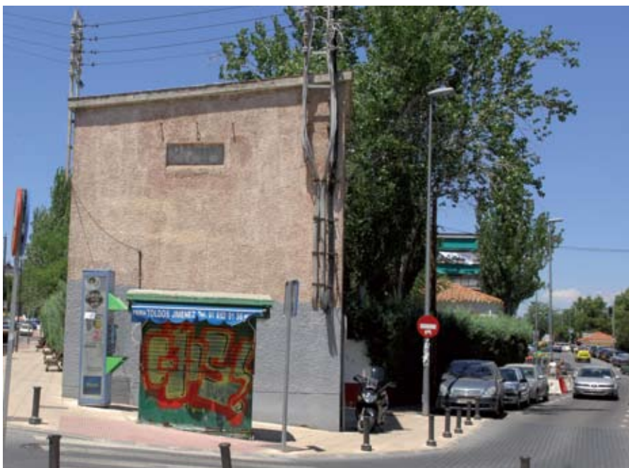
Otra de las grandes reformas que incluye esta obra es la eliminación y soterramiento del antiguo Centro de Transformación existente en la confluencia de la calle San Onofre con Avenida de Navarrondán.
