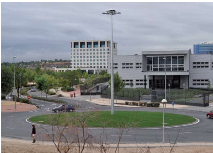
Así ha quedado la rotonda después de las obras acometidas.
