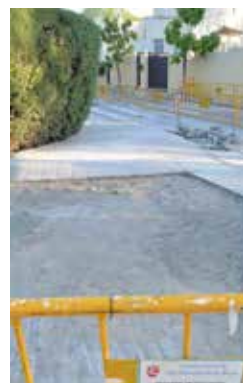
▲ Obras en Lomas del Rey.
