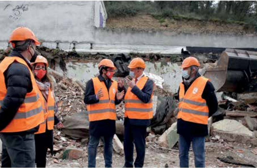
▲ En Fuente el Fresno se han acometido demoliciones por motivos de seguridad.
