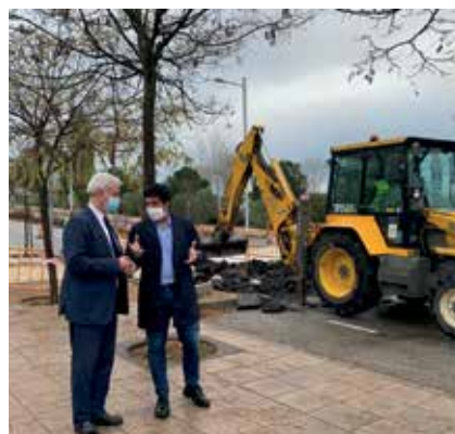
▲ El alcalde y el vicescalde, al pie de las obras para suavizar y eliminar badenes.
