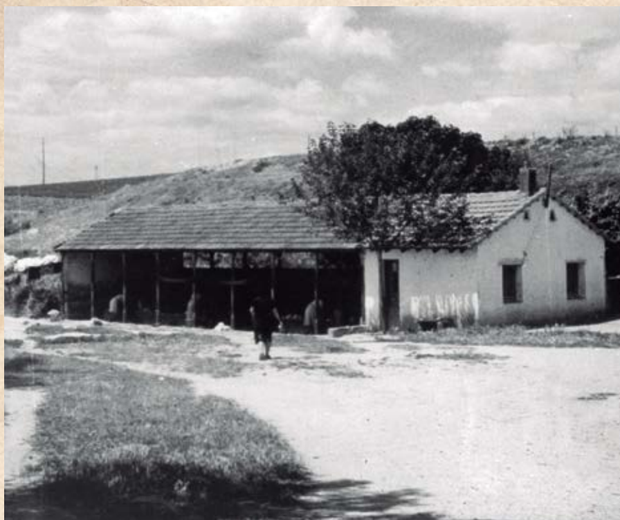
Vista antigua del lavadero.
