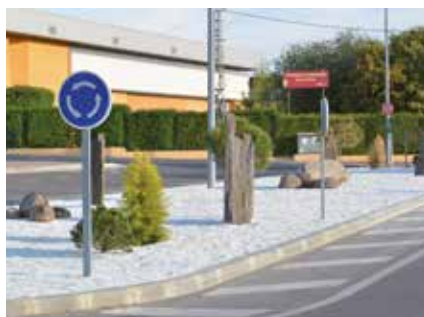
▲ Vista de la rotonda terminada.
