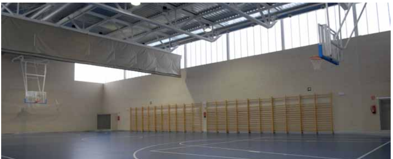
El pabellón se ha levantado sobre una superficie de 900 metros cuadrados, en la que se ha incluido una pista de 600 metros para la práctica del baloncesto y del balonmano.
