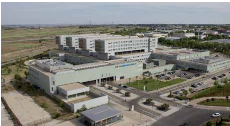
▲ Vista del Hospital Infanta Sofía donde han comenzado los trabajos del aparcamiento,
