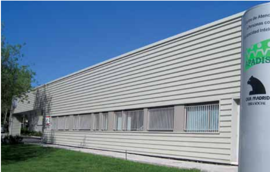
Así es la fachada del centro de Apadis, un complejo con toda clase de servicios.
