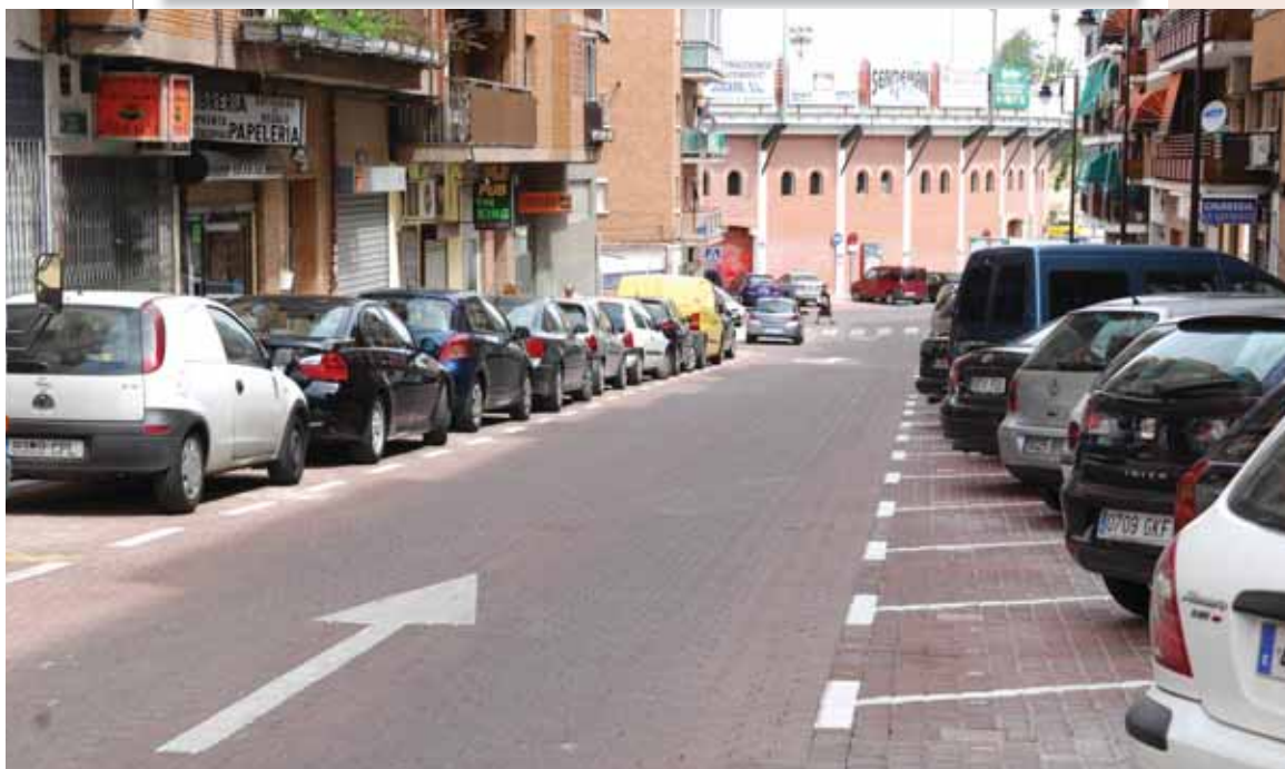
El Ayuntamiento acaba de finalizar la obra de reurbanización de la calle Estafeta, sólo una de las muchas acciones de mejora y mantenimiento de vías públicas que se están acometiendo este año.
