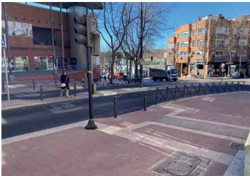
▲ En la calle Asturias se ha llevado a cabo una actuación para mejorar la visibilidad y la seguridad de vehículos y peatones.
