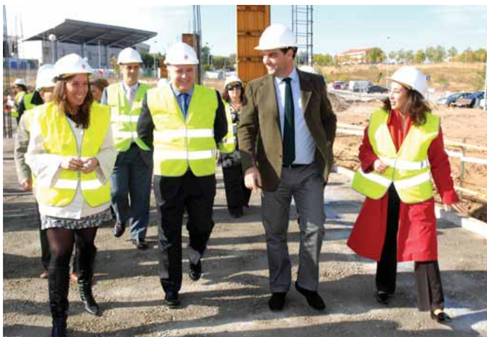
El alcalde, Manuel Ángel Fernández, pasea por los terrenos donde se construirá la escuela junto a la concejala de Educación, Lorena Heras, y la concejala de Urbanismo, Mar Escudero.
