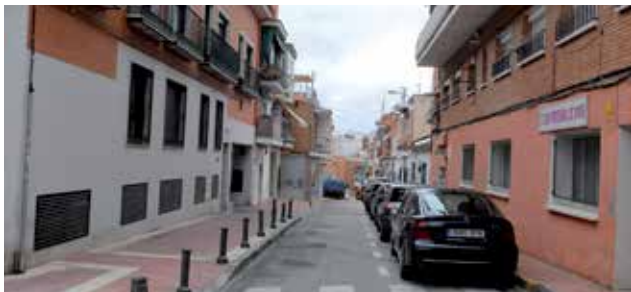
Travesía donde se están empezando a acometer las reformas.
