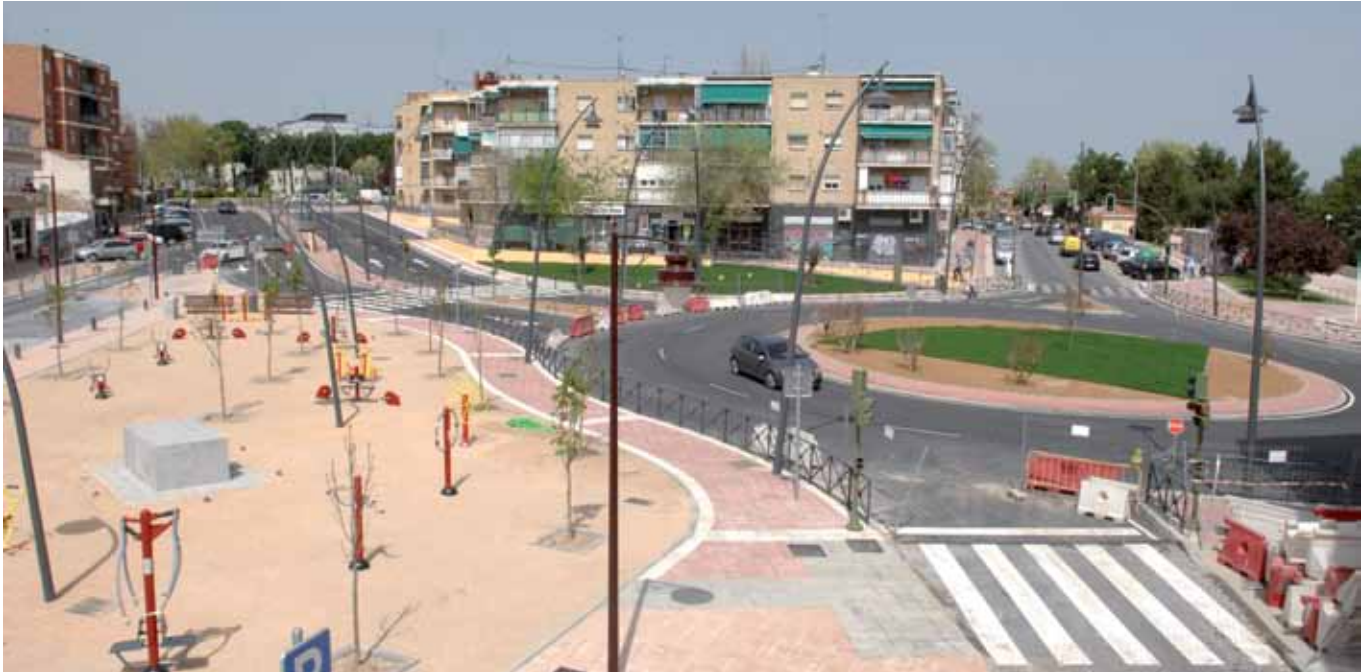
Vista de las obras tal cómo están quedando, con las zonas recreativas y la nueva glorieta ya en funcionamiento.
