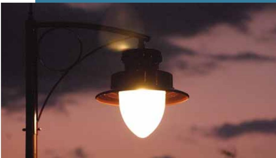
El Ayuntamiento ha cambiado las lámparas de sodio de alta presión por otras de halogenuros metálicos, ganando en luminosidad y ahorro. La renovación se ha realizado en todas las calles del casco histórico, así como en las avenidas de Baunatal y de la Sierra,
